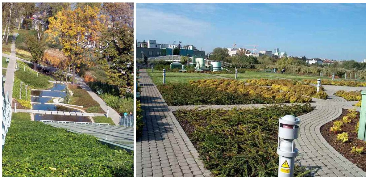
Rysunek 2.1. Park wokół budynku i dach Biblioteki Uniwersytetu Warszawskiego
